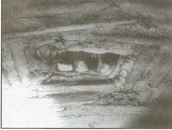
Resim 5: Tünellerde yer yer gözlenen tonoz örtü
