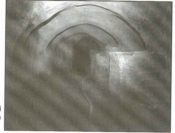
Resim 2: İç narteksin altındaki tonozlu mekân ve ayaklardaki destekler
