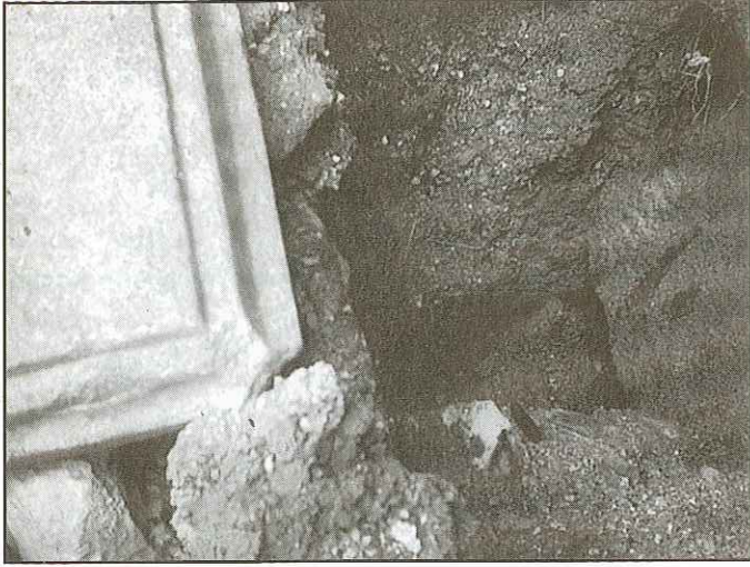
Resim 9: Ayasofya'nın kuzey bahçesindeki çökmüş tüneller
